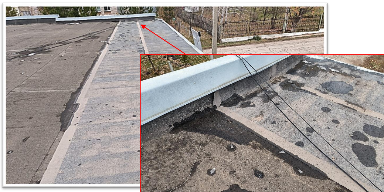
Фото Б.27 – В 2-х последних рядах по направлению уклона рулонный материал покрытия уложен с нарушениями – стыки по направлению уклона; отслоение в нахлесте и следы замачивания в стыках по оси 1-4/В-Г
