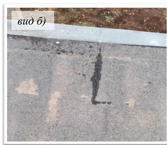
Фото Б.30 – Трещины в рулонном материале покрытия: вид а) – по оси 1-2/В-Г, вид б) – по оси 2-3/В-Г
