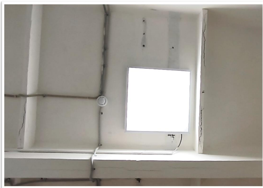
Фото Б.19 – Продольные трещины в отделке на стыках ребристых плит перекрытий, продольные трещины в поперечных ребрах ребристых плит по оси 3-4/В-Г
