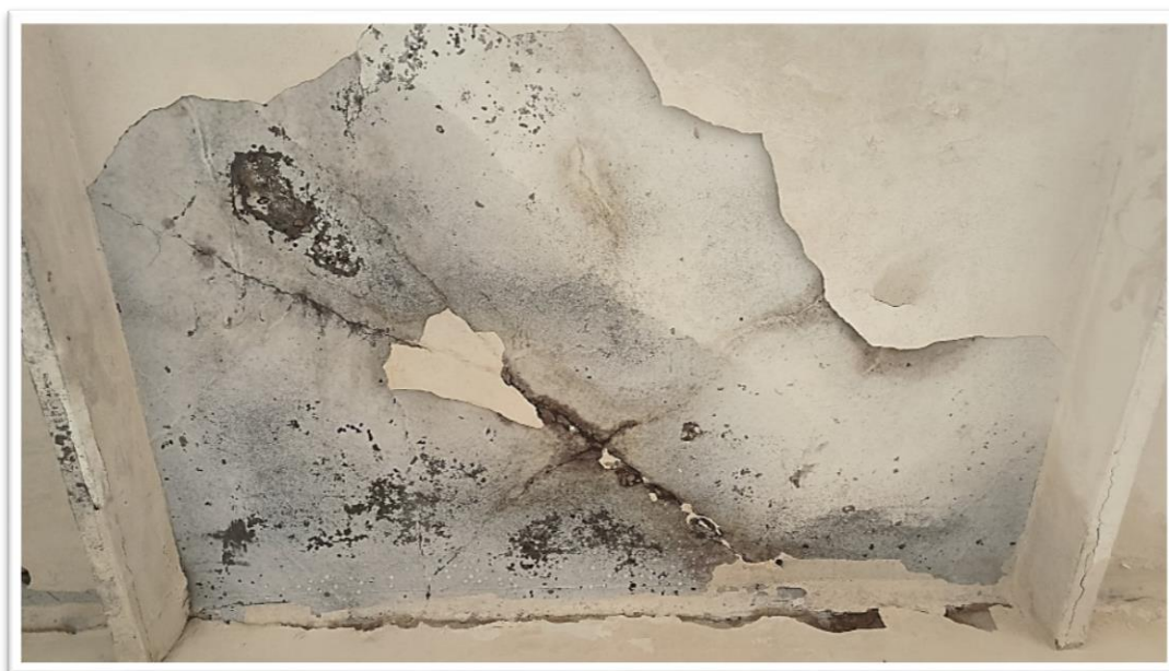
Фото Б.18 – Следы замачивания ребристых плит перекрытия, наклонные трещины в плитах, разрушение отделки по оси 3-4/В-Г
