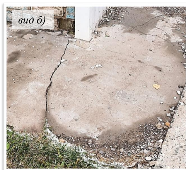
Фото Б.10 – Сквозные трещины в отмостке:
