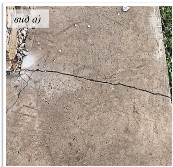
Фото Б.10 – Сквозные трещины в отмостке:
