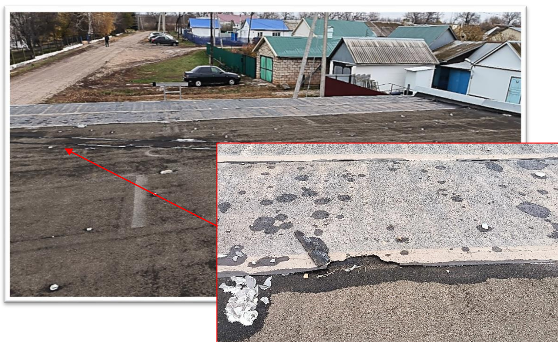
Фото Б.26 – В 2-х последних рядах по направлению уклона рулонный материал покрытия уложен с нарушениями – стыки по направлению уклона; отслоение в нахлесте и следы замачивания в стыках по оси 1-4/В-Г
