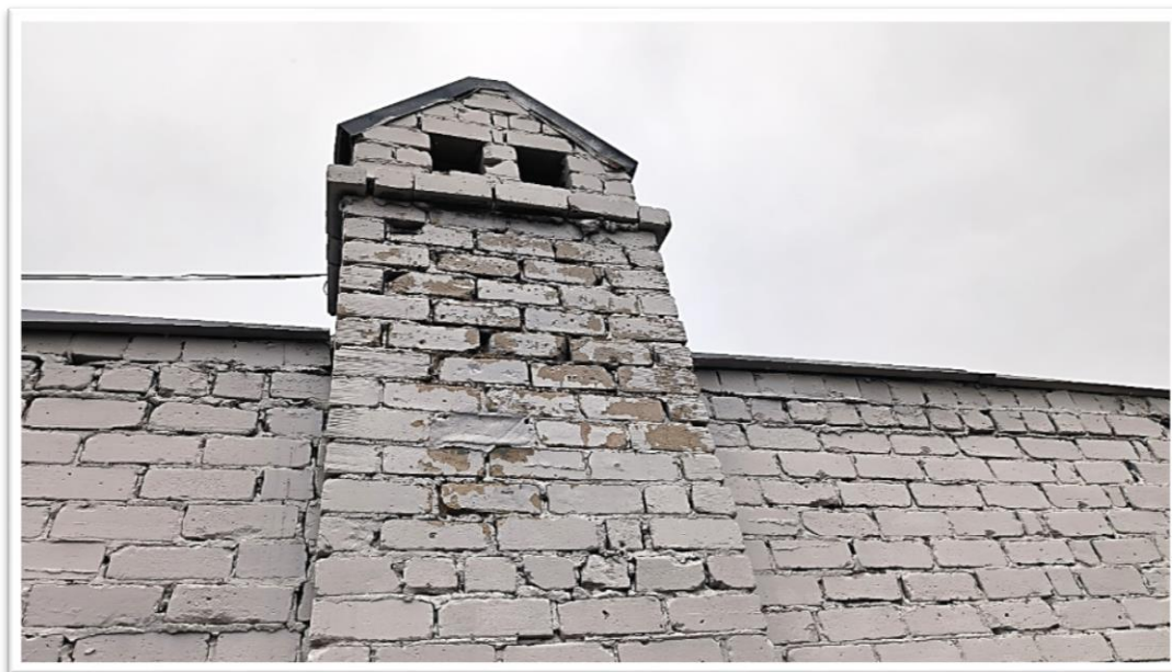
Фото Б.7 – Следы замачивания стен, локальное отслаивание фасадной отделки; выветривание кладки, пустошовка по оси 4/Б
