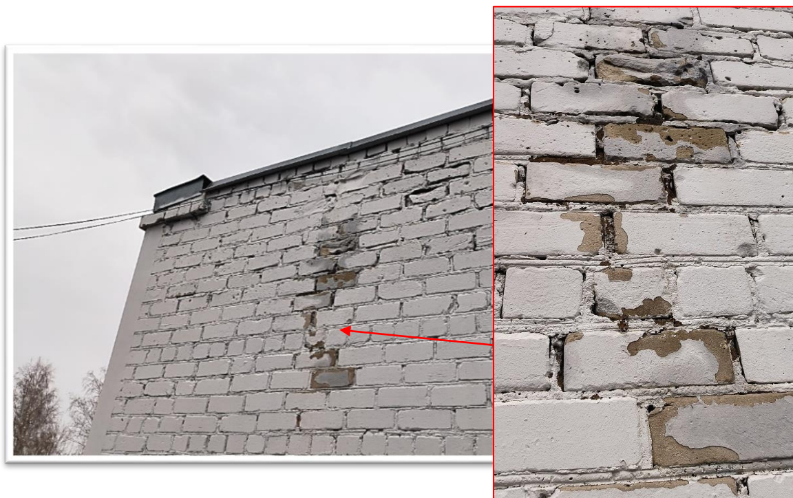
Фото Б.5 – Неплотное прилегание отмостки к зданию, в месте примыкания отмостки здания растительность, локальное разрушение силикатного кирпича цоколя по оси 4/А-Г
