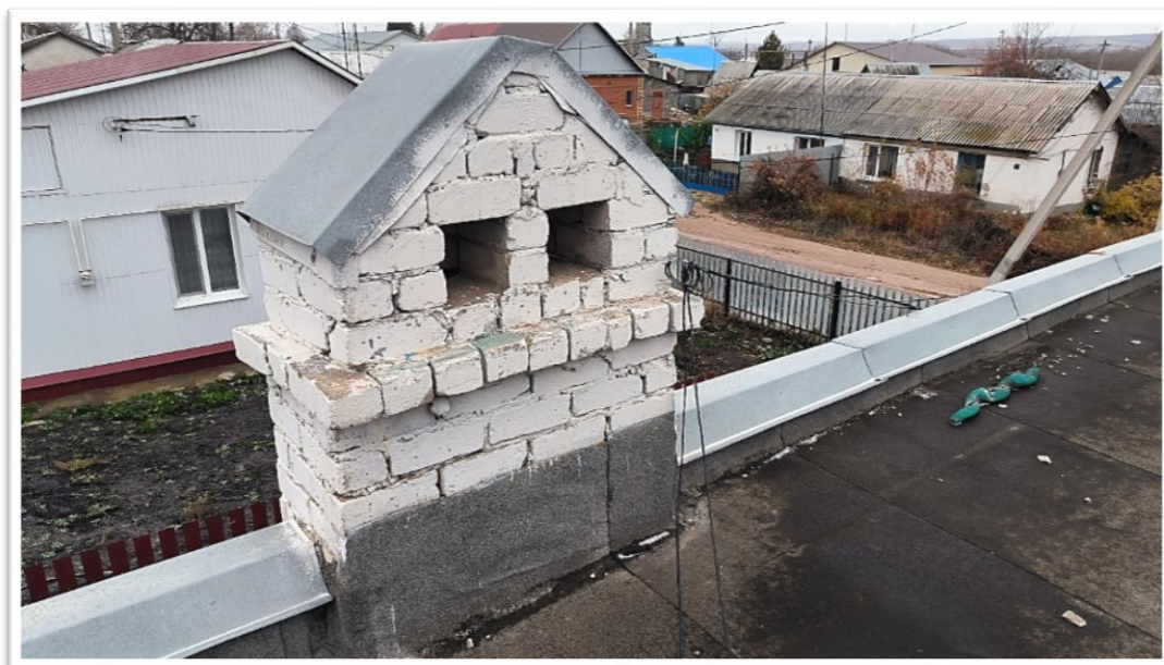
Фото Б.29 – Технологические нарушения в устройстве фартуков над вентканалом по оси 4/Б
