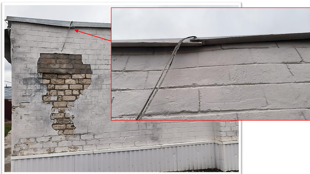
Фото Б.13 – Следы замачивания стен с фартуков парапета, локальное отслаивание фасадной отделки; выветривание кладки по оси 1/В-Г
