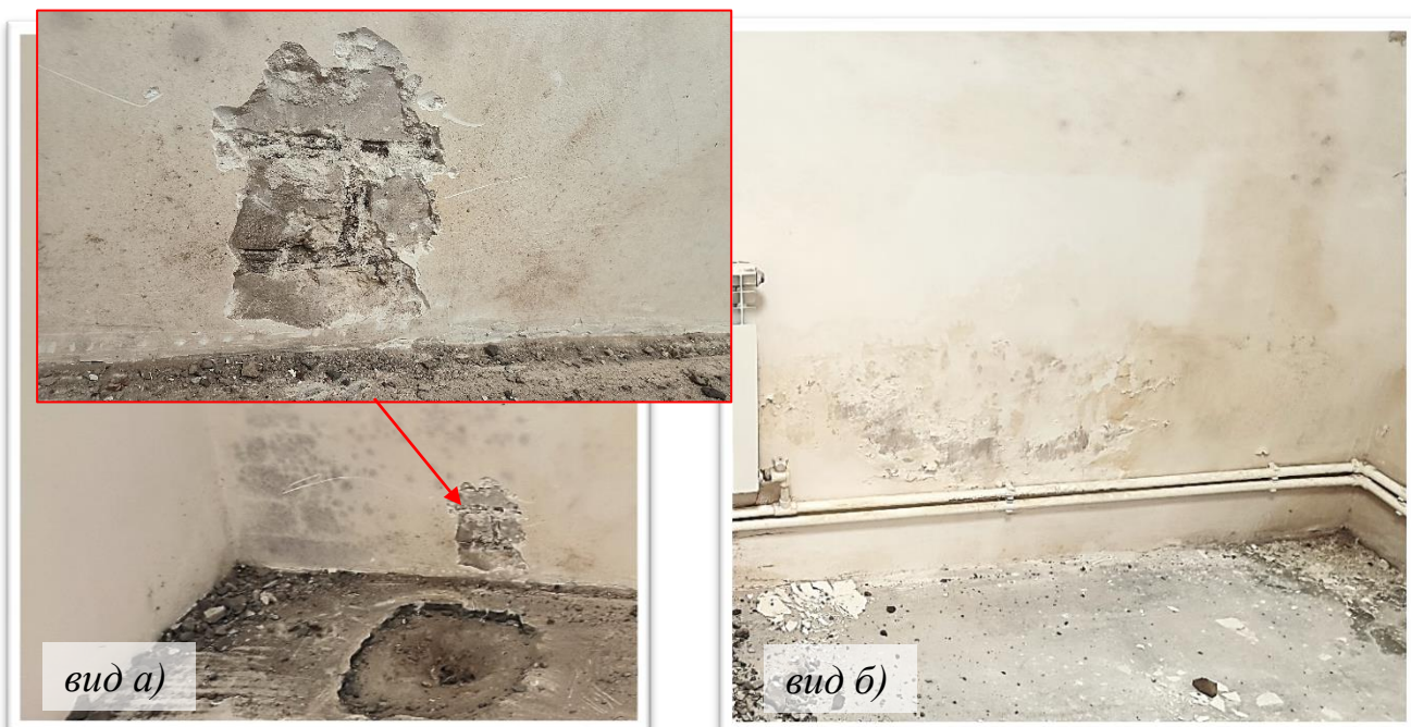
Фото Б.23 – Следы замачивания кладки ниже уровня земли, наличие грибковых повреждений, для кладки цоколя ниже уровня земли используется силикатный кирпич: вид а) – по оси 1/Г-В, вид б) – по оси 1/В-Г
