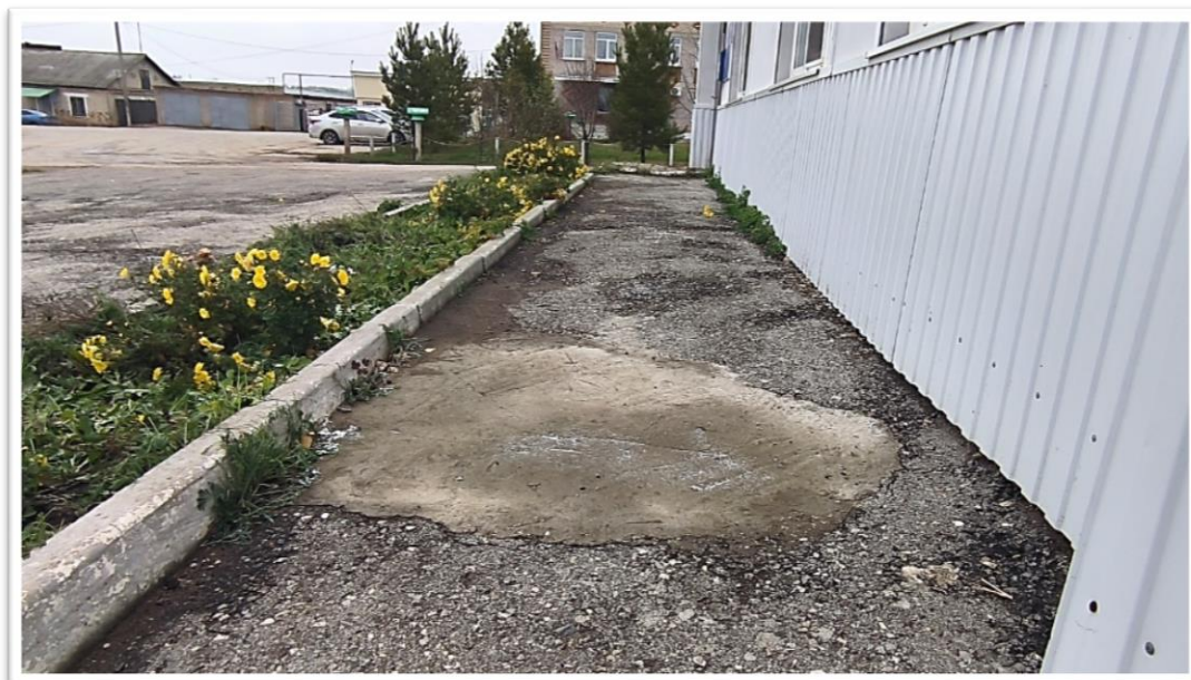
Фото Б.2 – Ремонтные бетонные вставки в асфальтобетонной отмостке – частично разрушены по оси А/3-4
