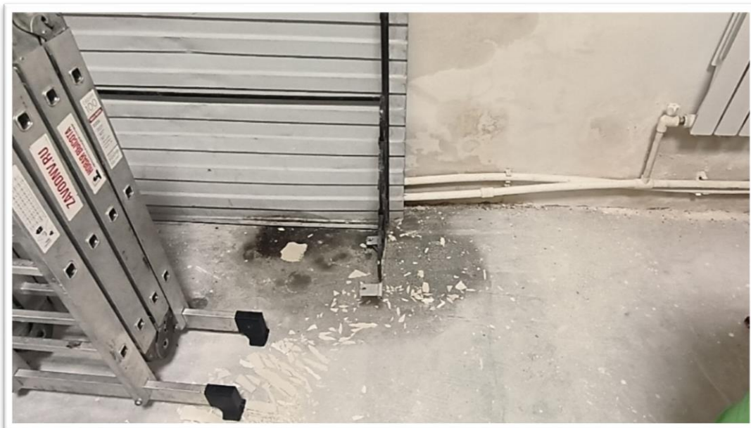
Фото Б.20 – Следы замачивания бетонного пола по оси Г/3-4
