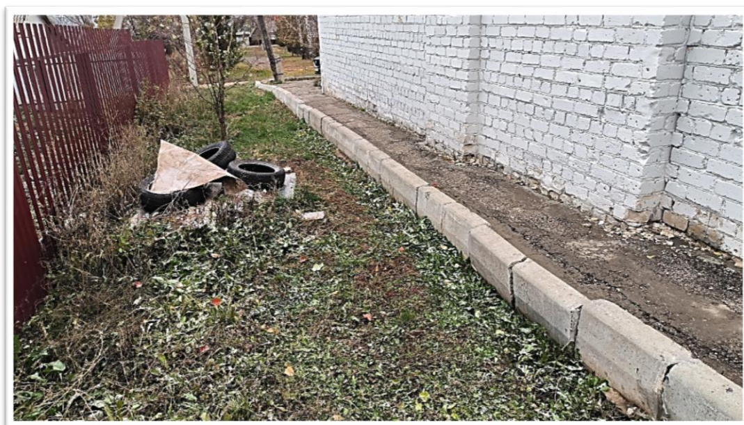
Фото Б.8 – В 1 метре от отмостки находится выгребная яма – уклон грунта в сторону отмостки по оси 4/Б
