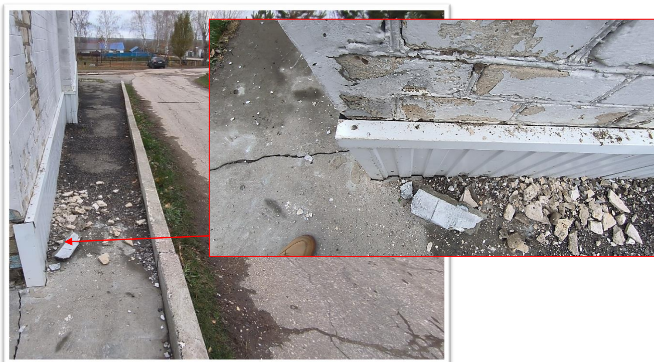
Фото Б.14 – Неплотное прилегание отмостки к зданию и бордюрам, высота бордюров выше отмостки на 15-20 см по оси 1/А-Г
