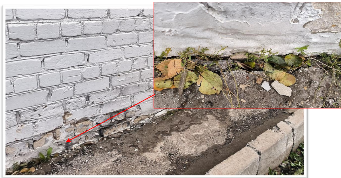
Фото Б.5 – Неплотное прилегание отмостки к зданию, в месте примыкания отмостки здания растительность, локальное разрушение силикатного кирпича цоколя по оси 4/А-Г
