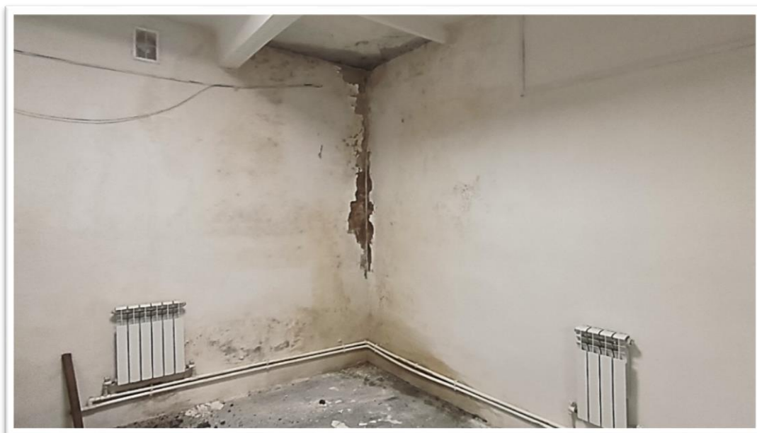
Фото Б.22 – Следы замачивания стены на всю высоту этажа, наличие грибковых повреждений, разрушение отделки по оси 1/Г
