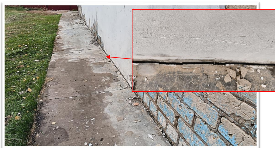
Фото Б.9 – Неплотное прилегание отмостки к зданию по оси Г/1-4
