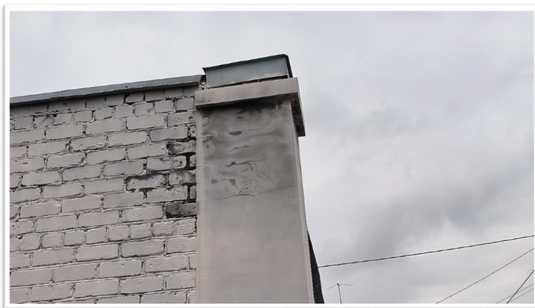
Фото Б.15 – Следы замачивания стен с фартуков парапета, локальное разрушение фасадной отделки; выветривание кладки по оси 1/А
