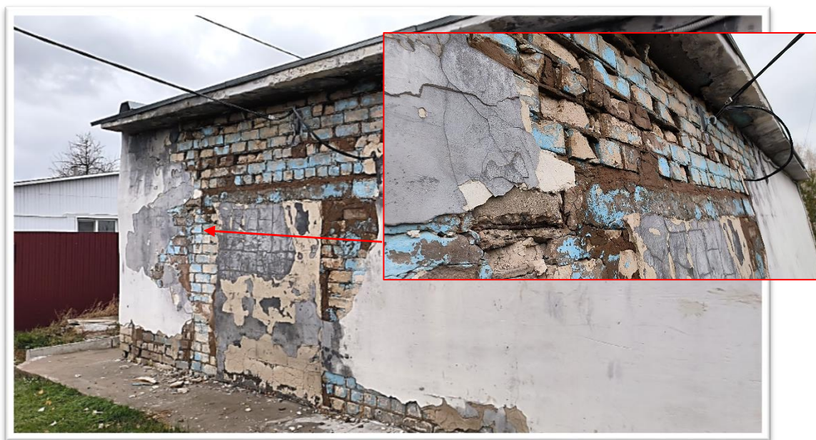
Фото Б.11 – Следы замачивания наружной стены по всей высоте здания, разрушение фасадной отделки, выветривание кладки, пустошовка по оси Г/3-4
