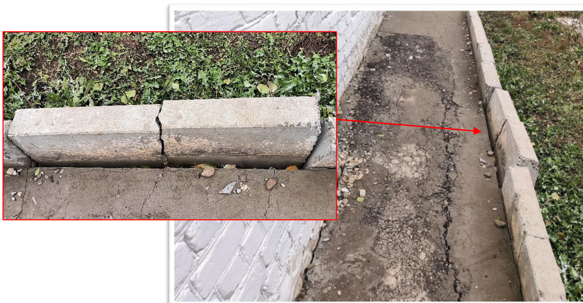
Фото Б.4 – Неплотное прилегание бордюров к отмостке по оси 4/А-Г
