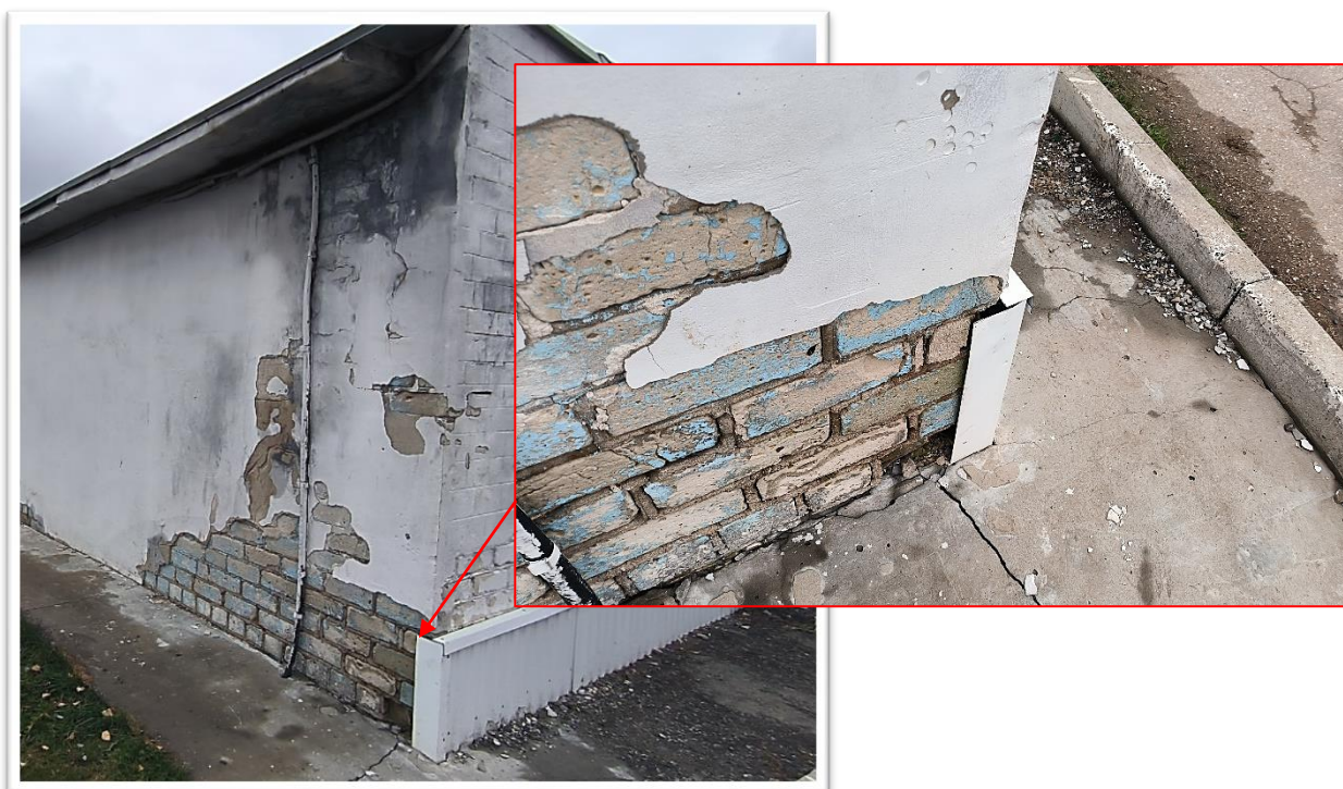
Фото Б.12 – Следы замачивания наружной стены по всей высоте здания, локальное разрушение штукатурки фасада, выветривание кладки, пустошовка по оси Г/1-2
