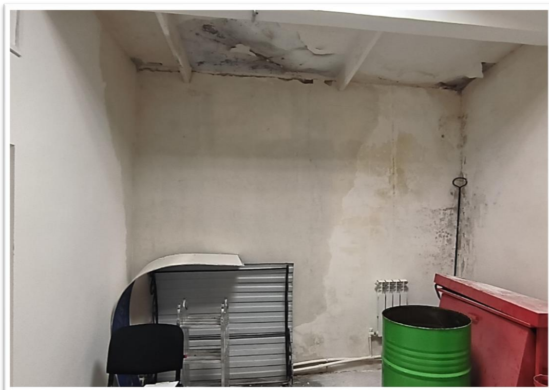
Фото Б.17 – Следы замачивания стены на всю высоту этажа, наличие грибковых повреждений по оси Г/3-4
