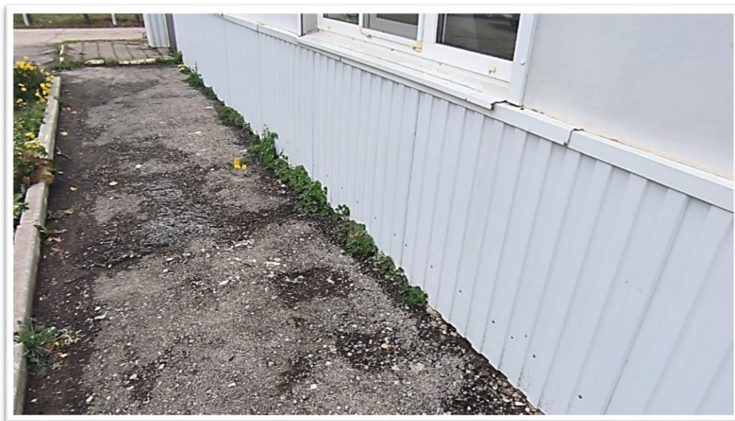
Фото Б.1 – Отверстия между отмосткой и отделкой цоколя, в месте примыкания отмостки к зданию растительность по оси А/1-4
