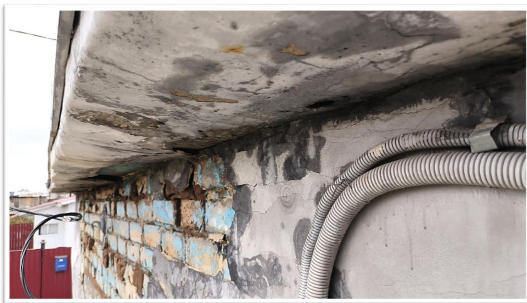
Фото Б.31 – Контруклон козырька свеса кровли, следы замачивания, разрушение отделки по оси Г/1-4
