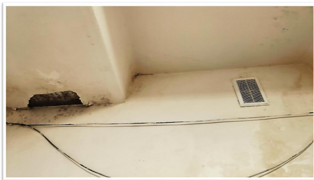
Фото Б.24 – Следы замачивания монолитного участка перекрытия, локальное разрушение отделки по оси 1/В
