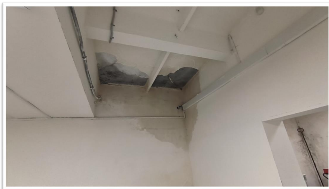
Фото Б.21 – Следы замачивания стены и ребристых плит перекрытия, разрушение отделки по оси 2-3/В
