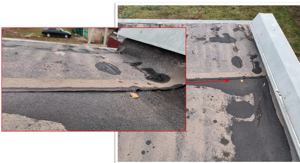
Фото Б.28 – В 2-х последних рядах по направлению уклона рулонный материал покрытия уложен с нарушениями – стыки по направлению уклона; отслоение в нахлесте и следы замачивания в стыках по оси 1-4/В-Г
